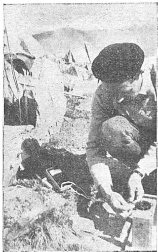
N° 1. — Poste n° 3.
