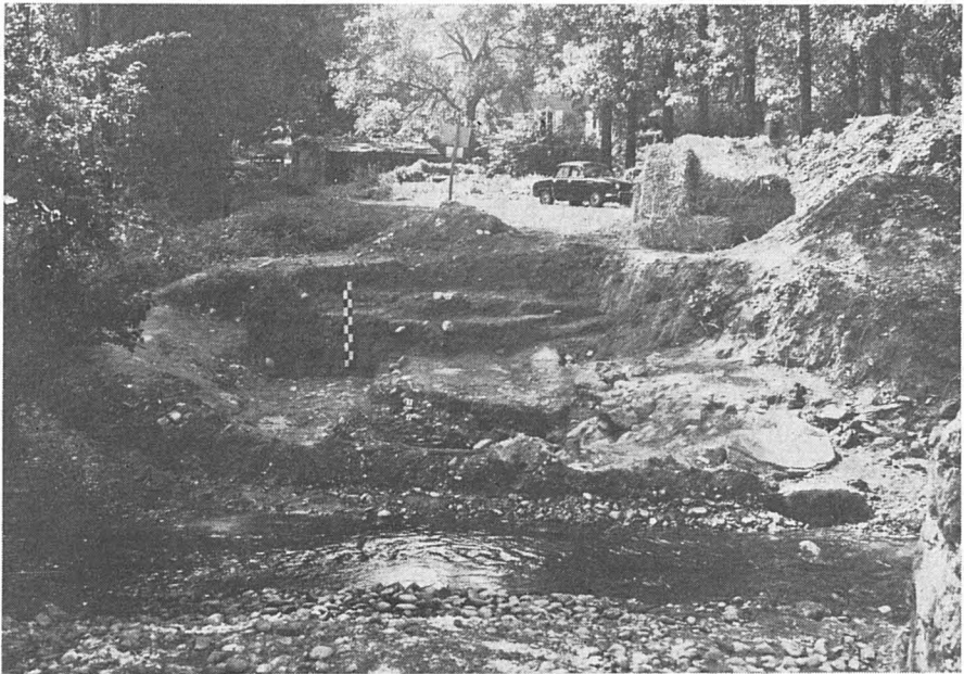
Fig. 2 — Le chantier de fouilles au terme des travaux. L'Ozon coule de gauche à droite, c'est-à-dire d'est en ouest. La première voie dégagée, la plus récente, apparaît nettement à droite, au sortir de l'eau. (Cliché G. Chapotat).
