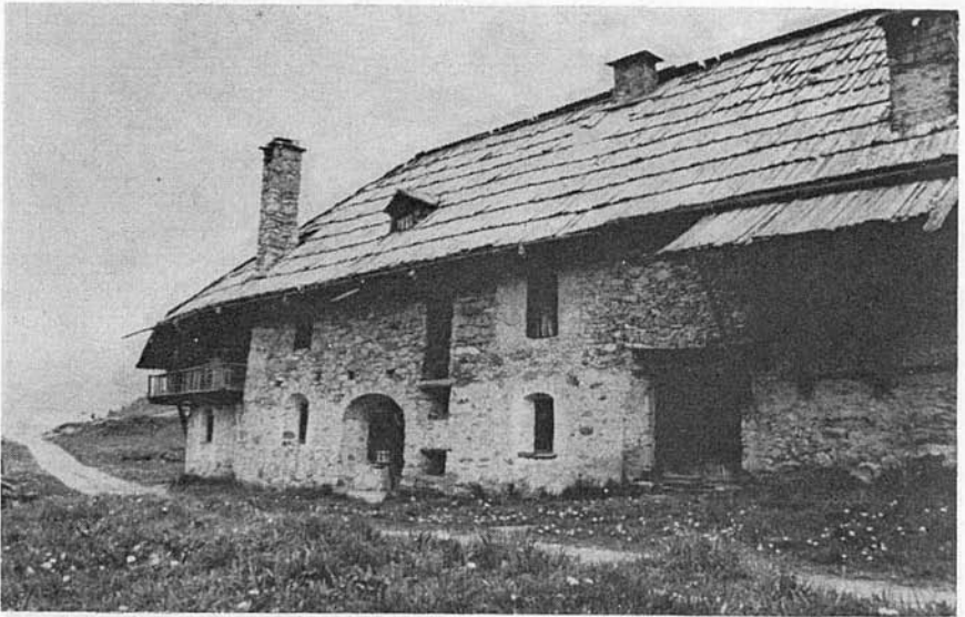
Photo 2. — Chalet d'alpage. Les tuiles sont des planches de mélèze et de pin cembro.
