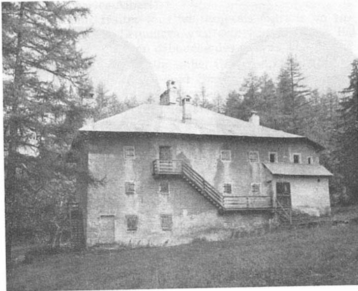
Etat actuel de l'ancien bâtiment de l'Ecole des Mines du Mont-Blanc à Peisey. (Document Société PENARROYA).
