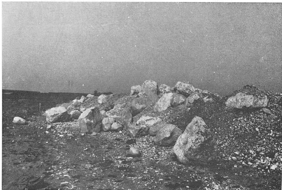
Pl. 3 — Stockage des gros blocs de toutes natures retirés du secteur NW de l'emprunt. Ces blocs gisaient sur les marnes bleues à lignites, vers — 7 m. Celui que l'on distingue au premier plan mesurait 1,50 m de haut.
