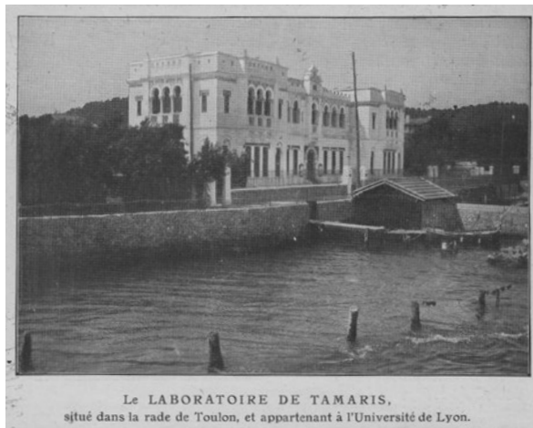
Figure 2. Vue générale du laboratoire.
