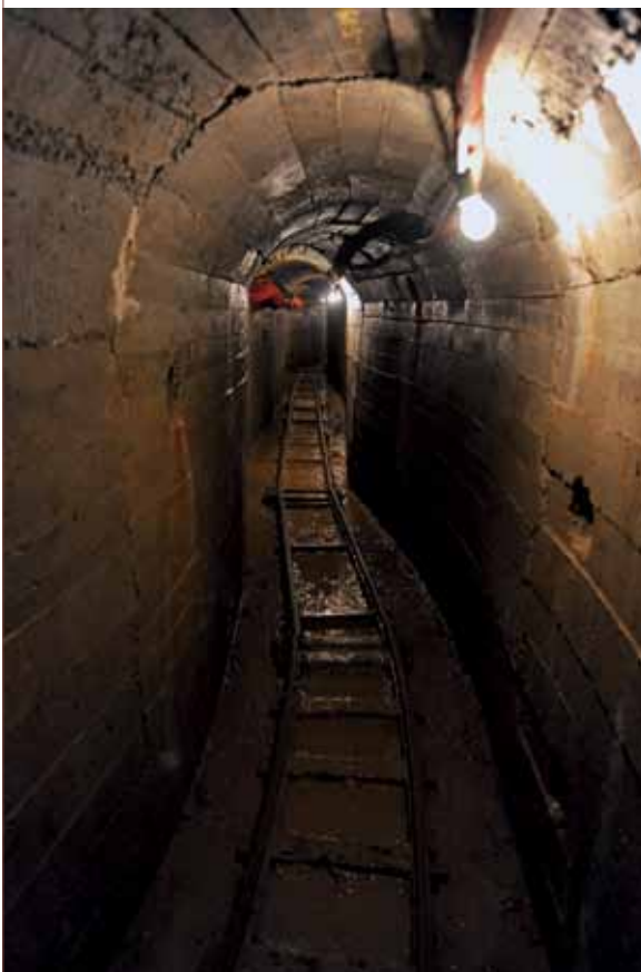
■ Deux exemples de galeries souterraines sous la Croix-Rousse : l'une aux parois renforcées à des fins de sécurité, la seconde taillée à même le substrat. © Jacques Léone - Grand Lyon
