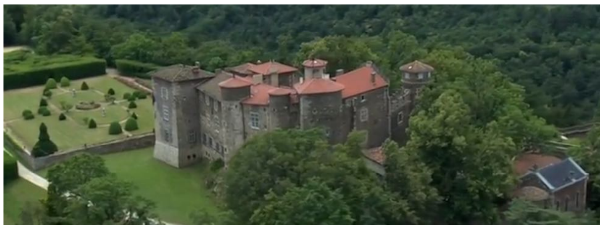
Château de Feugerolles. 13e siècle, 16e siècle, 17e siècle
