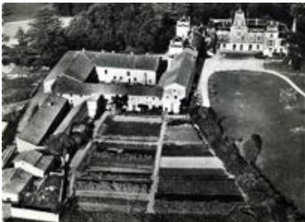
Les bâtiments du domaine de la Tourette à Eveux (Rhône). http://www.amis-arbresle.com/article.php?id_article=123 .
