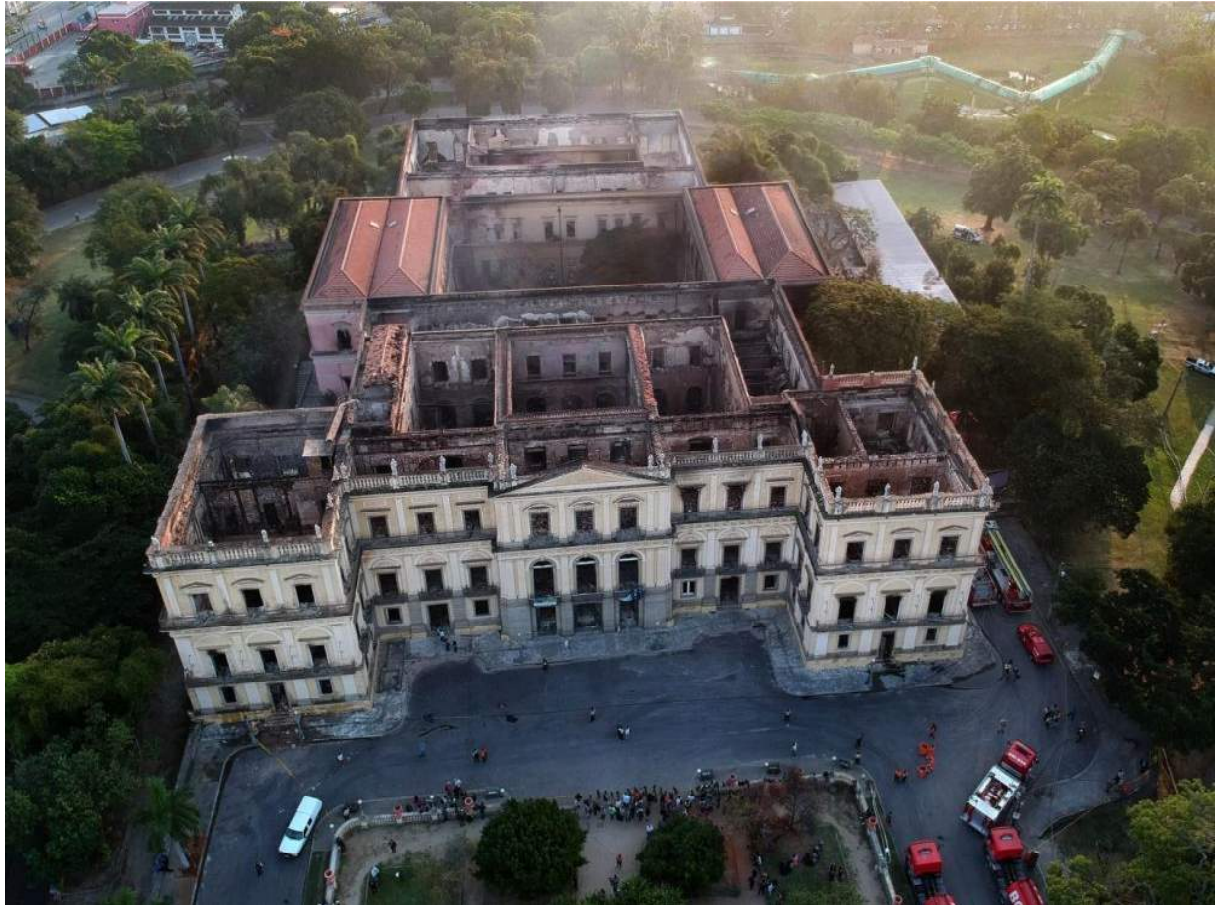
L'UFRJ, après l'incendie en 2018.
