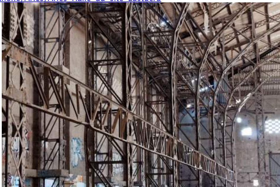
Halle du site Lusticru à Arles. Jonathan Dahan
